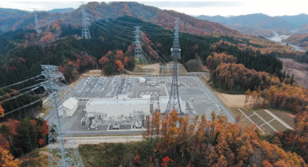
▲周波数を変える飛騨変換所 (写真提供：中部電力パワーグリッド株式会社)
