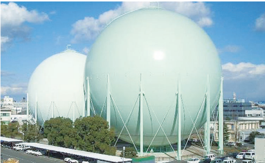
▲需給調整を行うガスホルダー (写真提供：東邦ガスネットワーク株式会社)
