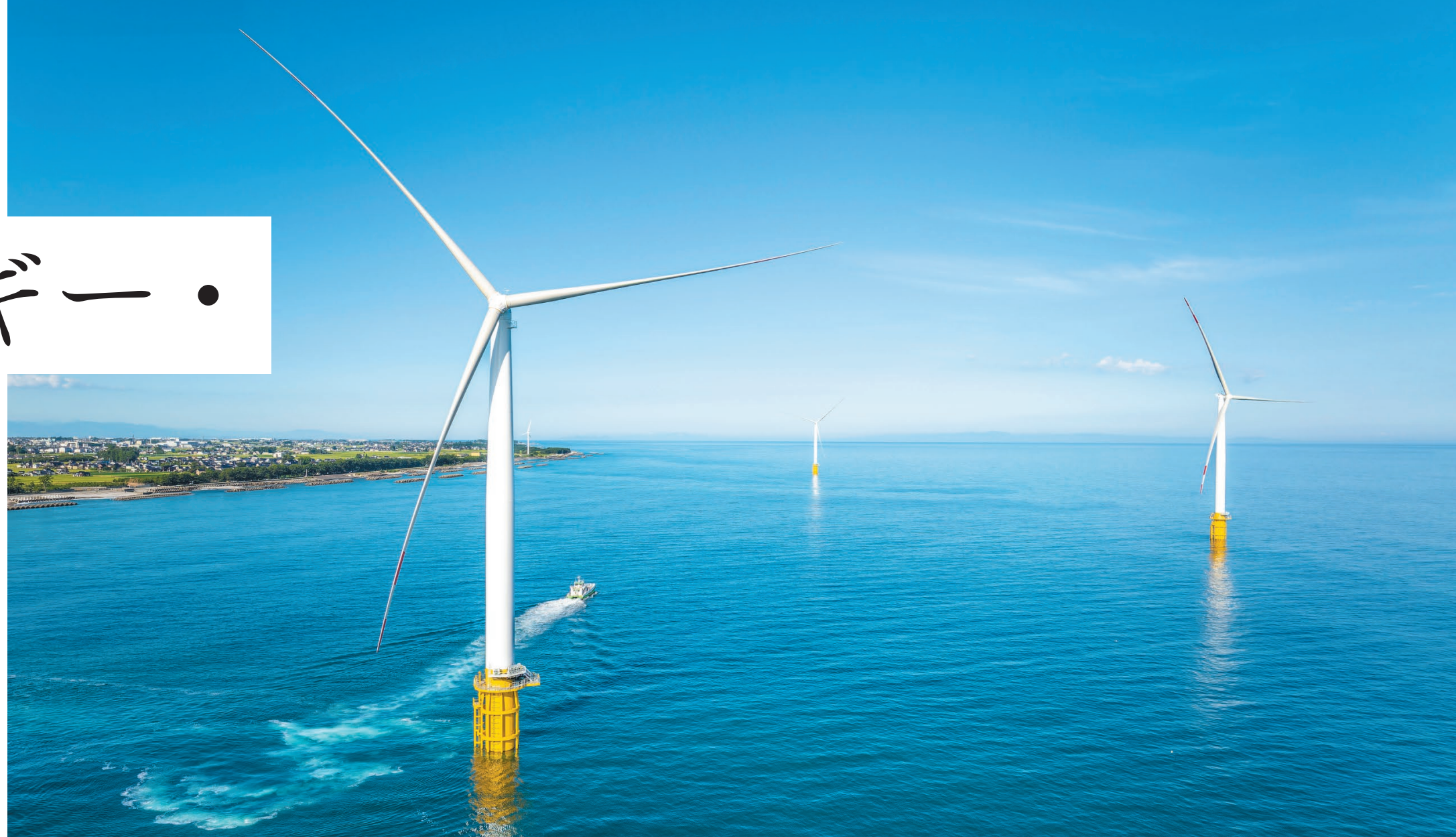
▲ 富山県下新川郡入善町「入善洋上風力発電所」(写真提供：株式会社ウェンティ・ジャパン)
