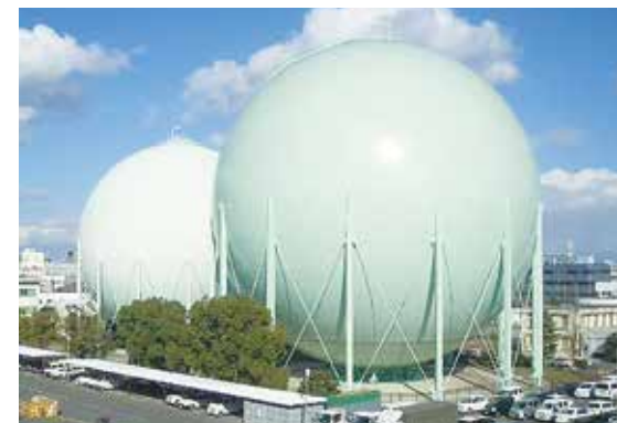
▲ 需給調整を行うガスホルダー (写真提供: 東邦ガスネットワーク株式会社)
