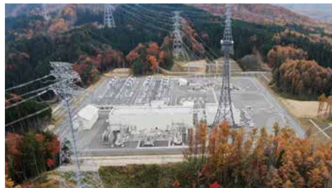
▲ 周波数を変える飛騨変換所(写真提供: 中部電力パワーグリッド株式会社)
