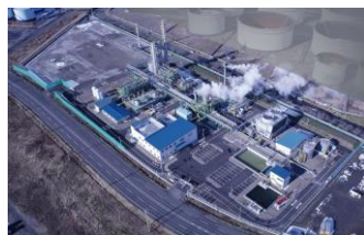
CO2分離・回収・貯留施設
