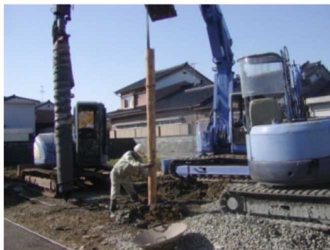
木杭打設の様子
