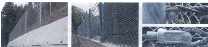
防護柵施工例
