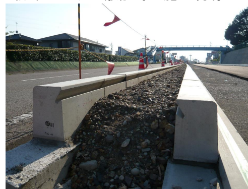
防草ブロック敷設時の施工現場
