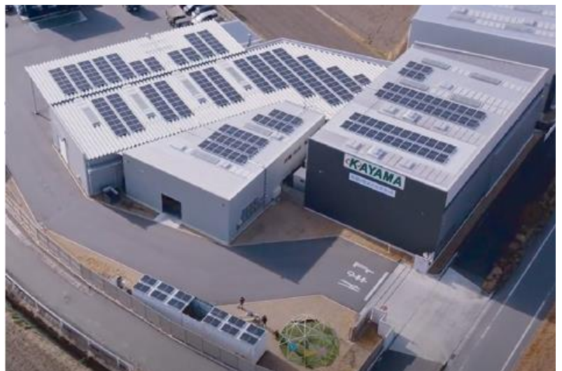
工場の屋根に太陽光パネルを設置
