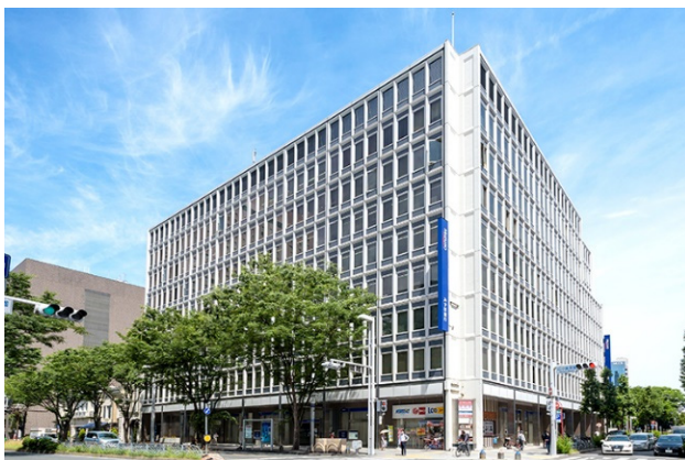
名古屋第一ビル
