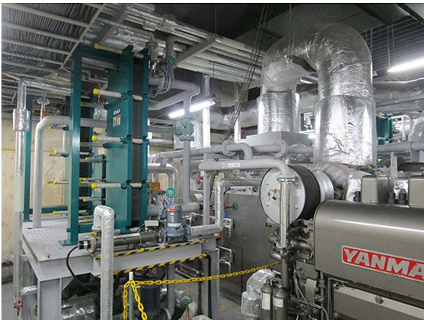
ディーゼルコジェネの廃熱回収熱交換器
