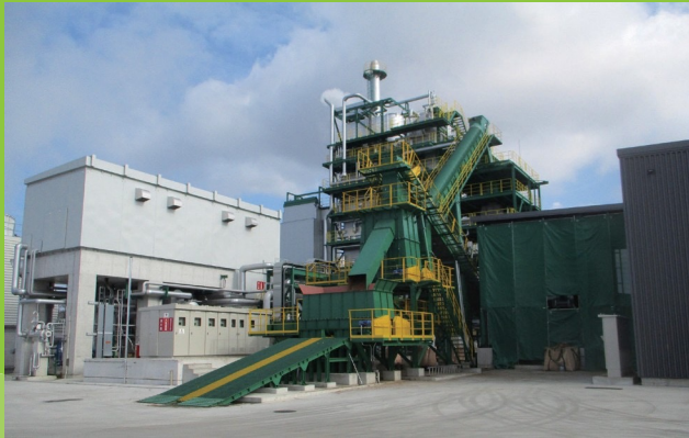
バイオマス発電所写真（BPS大東）
