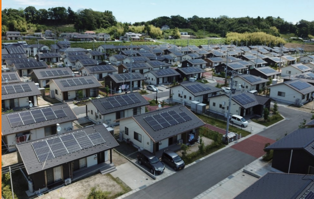
災害公営住宅屋根
