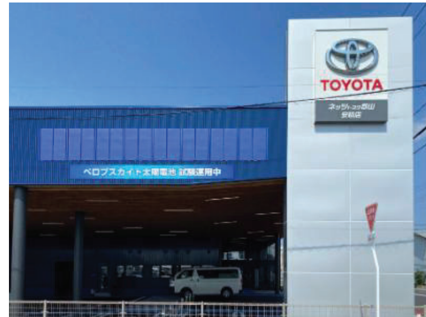
「ネットヨタ郡山 安積店」の店舗壁面に設置したペロブスカイト太陽電池
