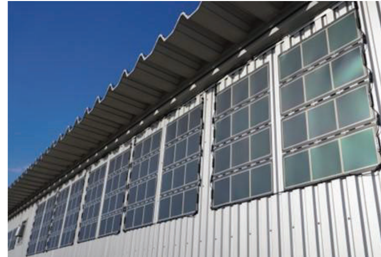
壁面への設置（南西面）
