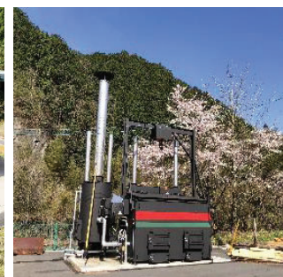
バイオマスボイラー
