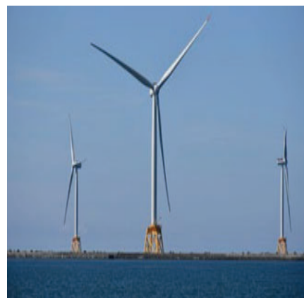
石狩湾新港洋上風力発電所
