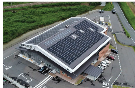
直方市汚泥再生処理センター導入された オンサイト PPA による太陽光発電設備
