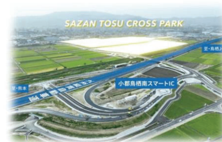
鳥栖市：100%再エネ提供をする団地造成（2030年頃完了予定）
