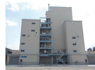
実証試験設備の外観
