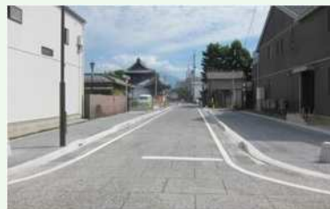
景観に配慮した保水性舗装（長浜市）
