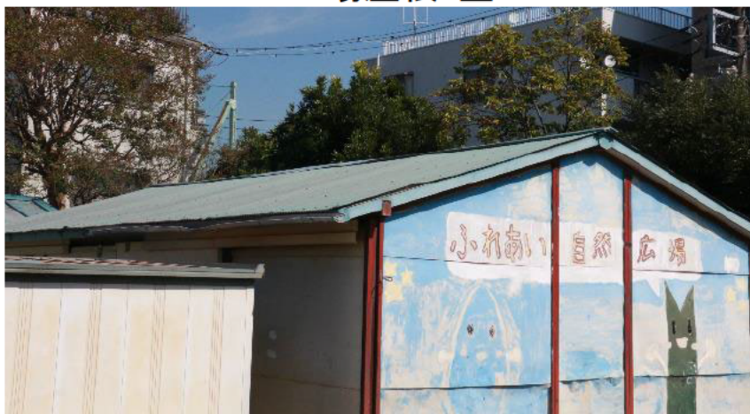
工場屋根・壁
