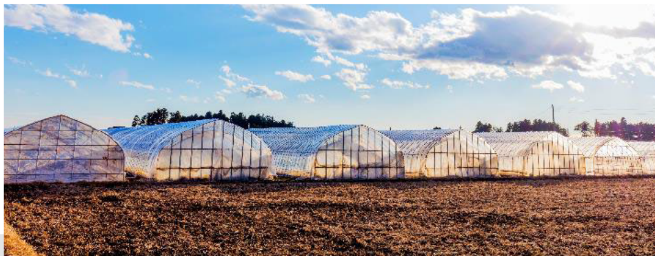
農業ハウス屋根
