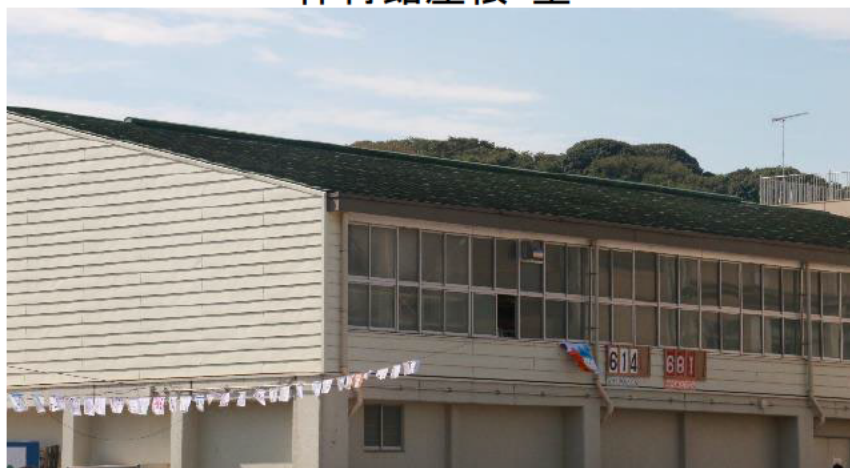
体育館屋根・壁
