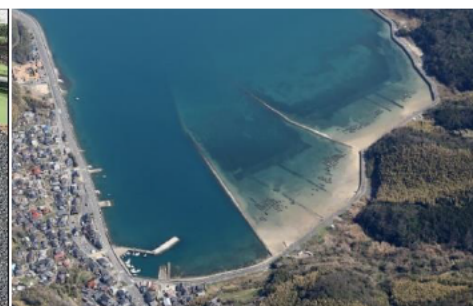
【浚渫土砂を活用した干潟の整備】
