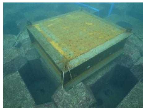
【藻場造成ユニット】 転炉系製鋼スラグと人工腐植土とを混合したもの。 (鉄分を供給)
