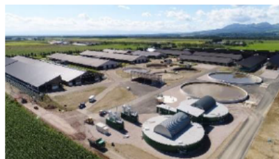
バイオガスプラント
