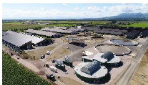
バイオガス発電設備
