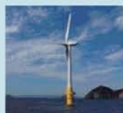
洋上風力発電施設
