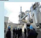
バイオマス発電所
