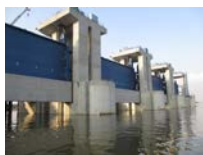
例：愛知県日光川水閘門
