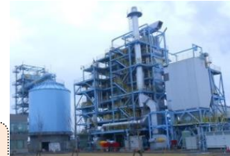
木質バイオマス発電施設
