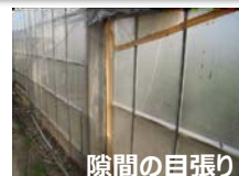
隙間の目張り
