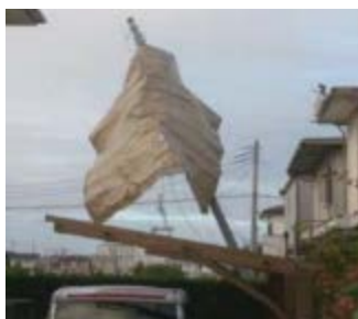
＜飛来物による電柱倒壊（東金市）＞
