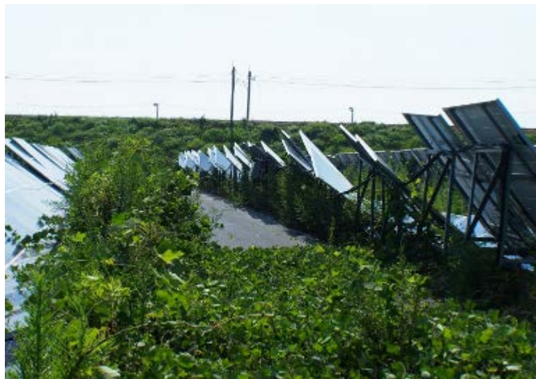
＜適正に管理されていない太陽光発電設備の例＞
