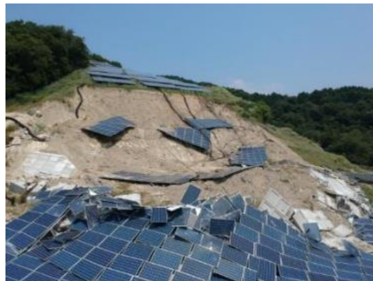
＜西日本豪雨による太陽光発電設備の被害例＞
