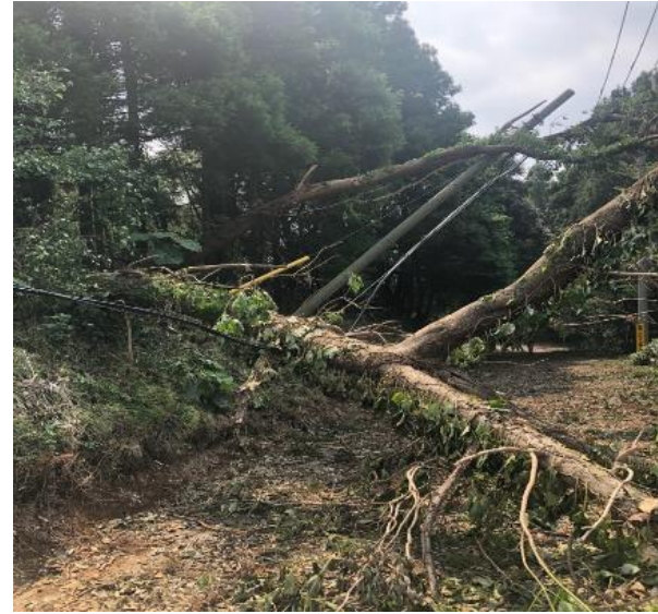
倒木による電柱倒壊（四街道市）
