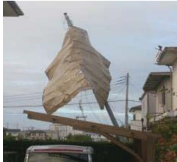
飛来物による電柱倒壊（東金市）
