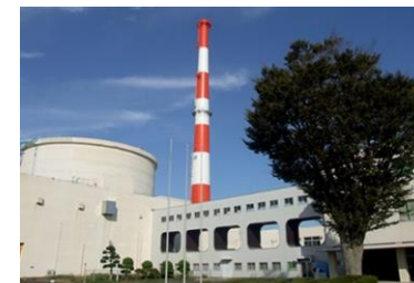
高速実験炉「常陽」
