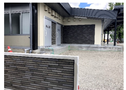
【当社製品が使用された 多治見市内の施工現場】
