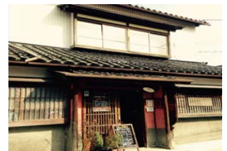
【金澤町家の外観】
