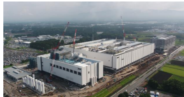
菊陽町におけるTSMCの建設現場（2023年8月）
