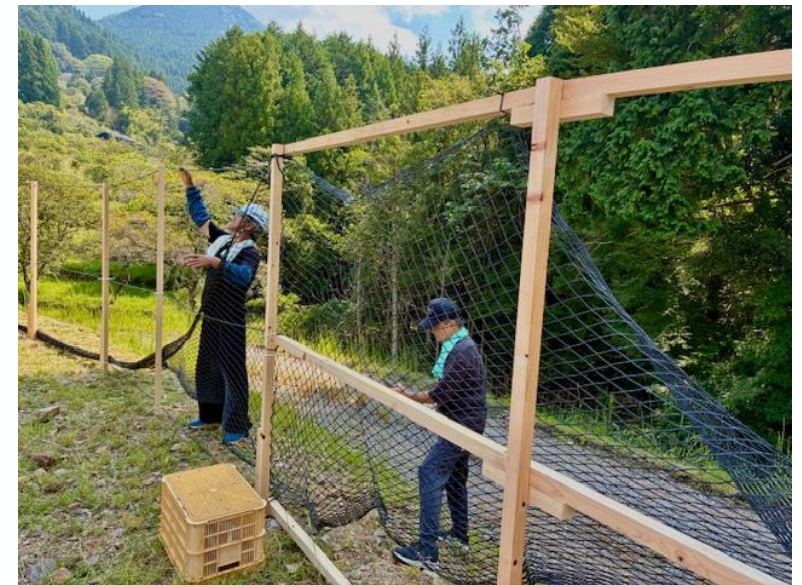
生分解性防獣ネットの設置風景 (出所：(株)豊栄工業 HP( https://www.hoic.co.jp/2025/10/1665/ ))
