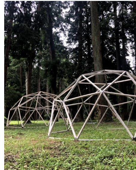
hitode bracketを活用して組み立てた半球ドーム （出所：(株)加藤数物HP ( https://hitode-bracket.com/about ))
