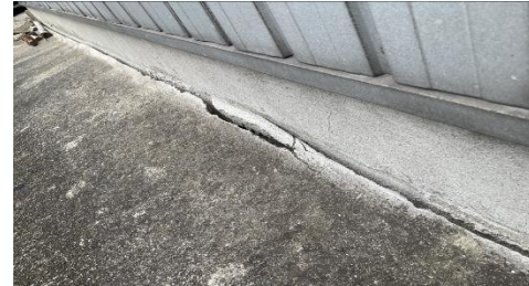
事務所の基礎部分における破損
