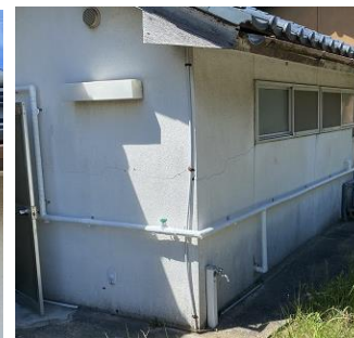
修繕した水道配管
