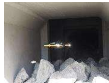
ドローンによる発電所の点検
