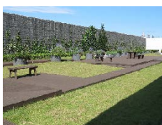
間伐材の利用による屋上緑化
