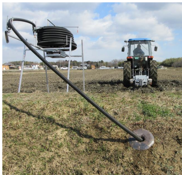
図 本暗きよの新設作業
