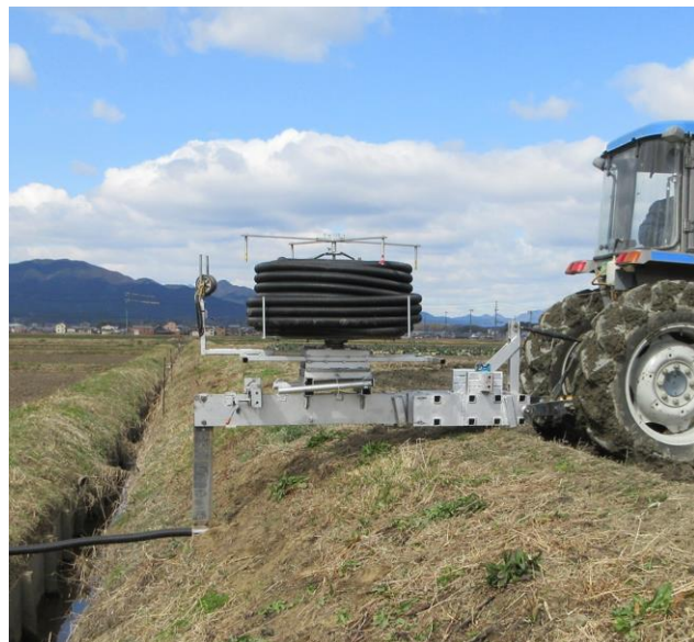
図 落水口の新設作業
