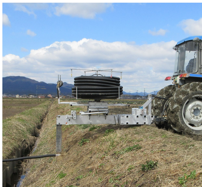
図 落水口の新設作業
