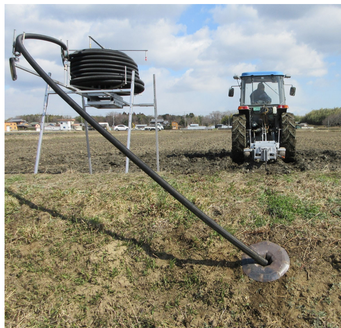
図 本暗きよの新設作業
