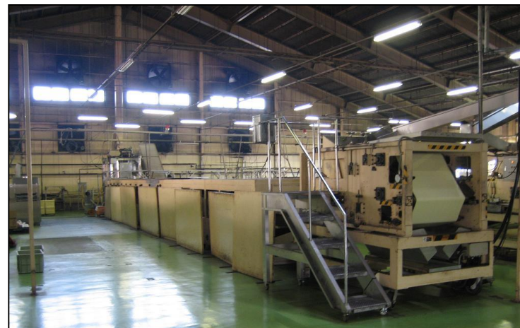
ガス式連続焼成機の全景
