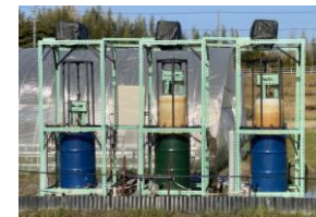
メタンガス 貯留供給装置
