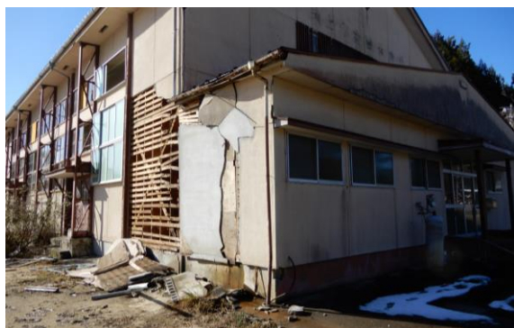
門前工場建屋は壁が落ちるなど大きな被害が生じた（左） 利用できなくなった工場敷地は、仮設住宅臨時駐車場として提供（右）
