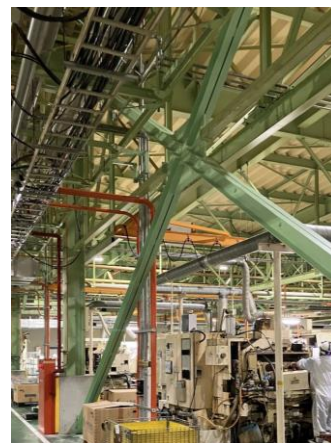
鉄骨の補強後
