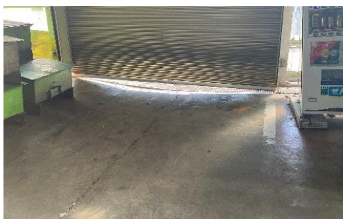
建屋が地盤沈下しシャッターに隙間が生じた（左）、修理後の様子（右）
