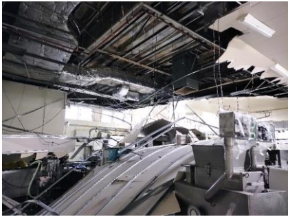
崩落した天井（左）、散乱する設備（中）、転倒した設備（右）
