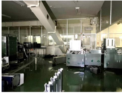
排気ダクトの落下（左）、設備や配電盤の転倒（右）
