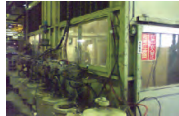
塗装ブースの外観
