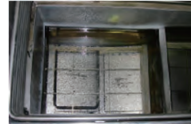
洗浄槽 (冷却水温度低い)
