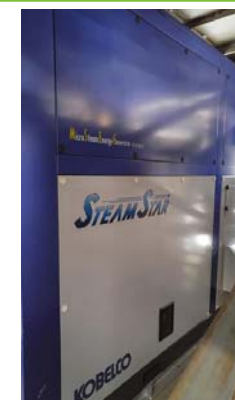
9号焼却炉未利用廃熱による蒸気発電機
