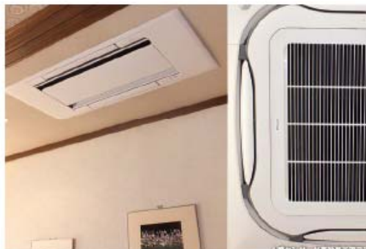
人感センサー付き高効率エアコン
