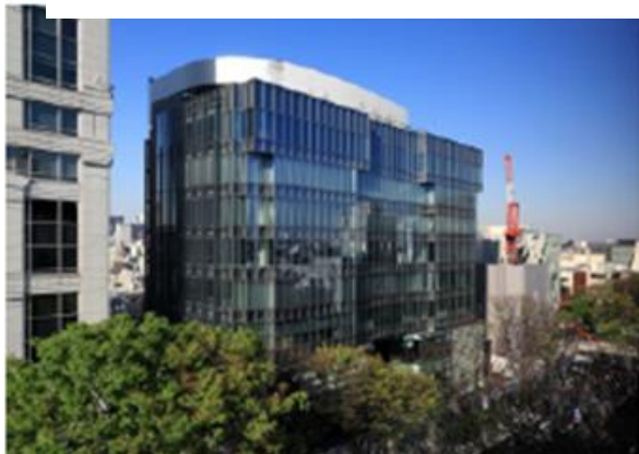
施工事例（オフィスビル、商業施設）
