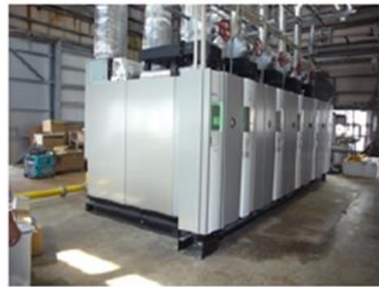
更新したLNG焚ボイラー 5基
