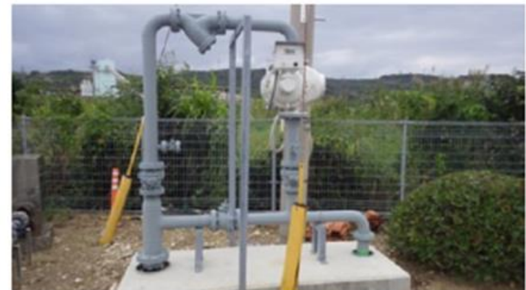
敷地内のLNGガスメーター
