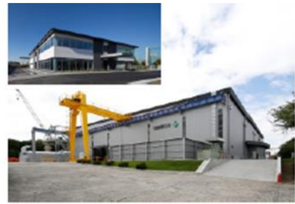
施工事例（工場）
