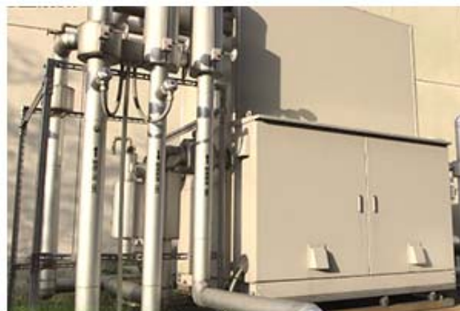
エネルギーコストとCO 2 削減のために導入した「ヒートポンプ」
