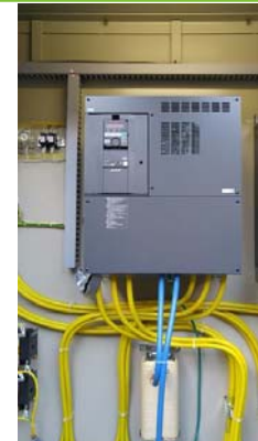
8号焼却炉ファンのインバーター制御
