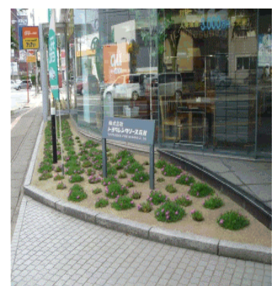
【はえん土の施工例】
