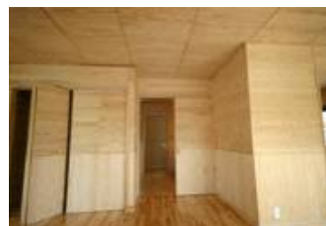
パネル工法施工例
