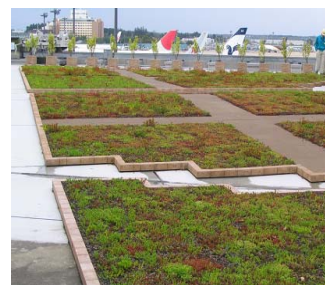
【施工事例：成田空港第2ターミナル】
